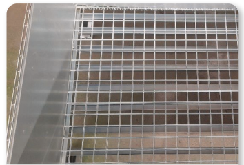
補強④ 底面フレーム補強
